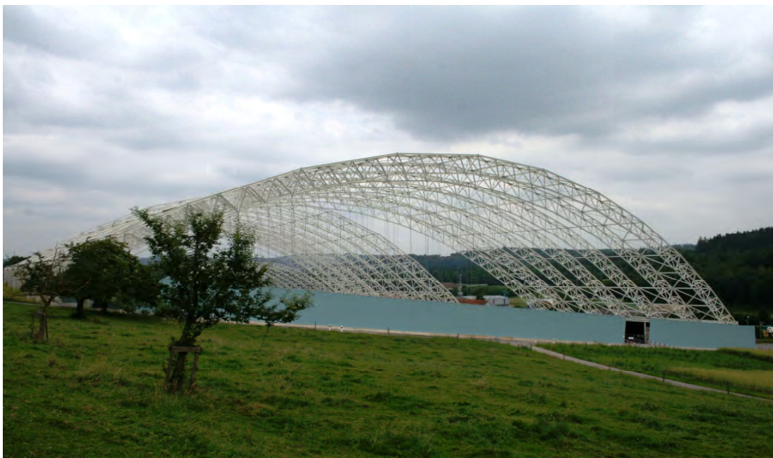
Abbildung 1: Halle für die Sanierung der Deponie Kölliken (Quelle: Wikipedia)
