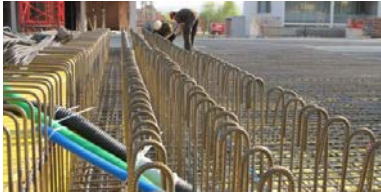
14. April 2010 Das Frühjahr erlaubt einen zügigen Baufortschritt. Bei Haus 01 konnte mit den Wänden über UG sowie den Treppenhauswänden, bei Haus 02 mit den Wänden im UG, bei Haus 03 die Decke über dem EG und bei der TG mit der Deckenschalung begonnen werden.
