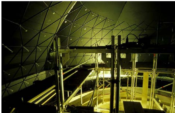
Meilenstein: Montage der inneren Planetariums-Kuppel
