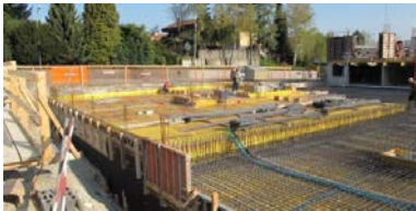
22. April 2010 3 Reihen Anschlussseisen für den Überzug der Tiefgaragendecke.
