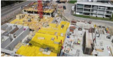
06. April 2010 Untergeschoss Haus 2 steht kurz vor der Fertigstellung.
